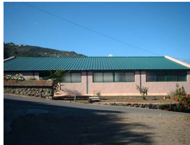
Foto 6: Vista de acabado exterior de explotación avícola
