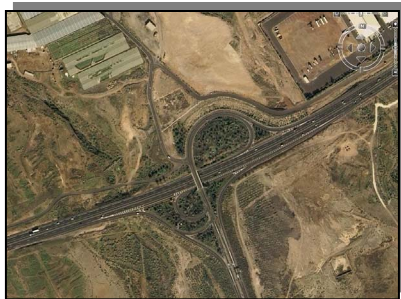
Enlace de Las Chafiras Este. Estado Actual.
