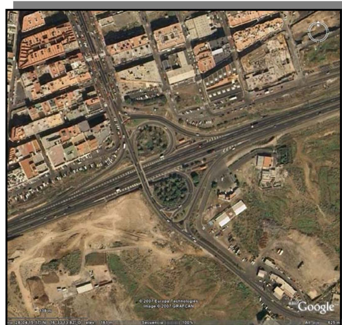
Enlace de San Isidro. Estado Actual.
