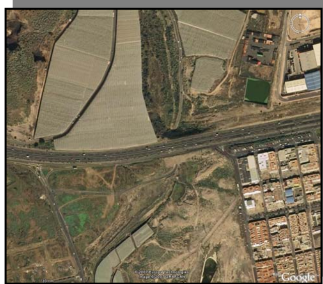
Enlace de Las Chafiras Oeste. Estado Actual.
