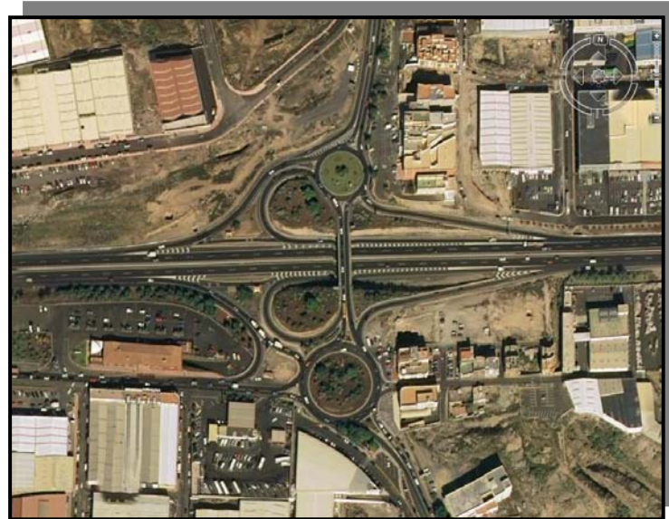
Enlace de Las Chafiras Este. Estado Actual.
