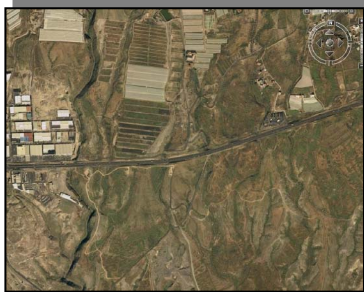
Enlace de Las Chafiras Este. Estado Actual.
