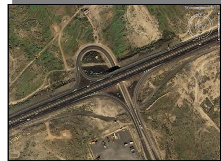
Enlace Oeste del Polígono industrial
