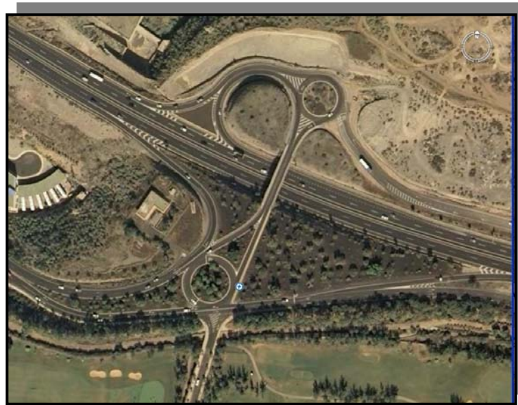
Enlace de Las Ameritas.. Estado Actual.
