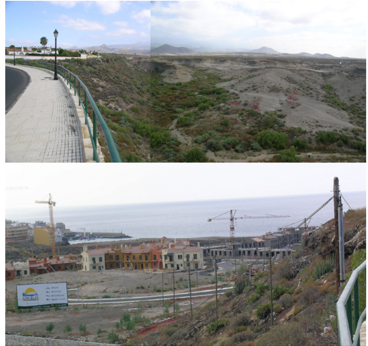
Fig. 46. Vistas Generales del Barranco de San Blas en la actualidad: imagen superior, vista hacia el interior, desde uno de los bordes de la actual urbanización turística; imagen inferior, obras en construcción en el borde litoral del barranco, que responden al Plan Parcial de desarrollo del Suelo Urbanizable del planeamiento general.
