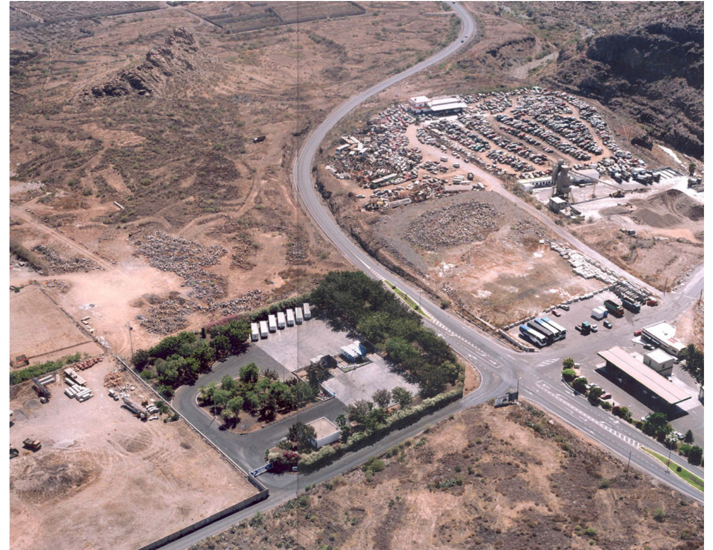
Fig. 51. Vista aérea de la Planta de Transferencia PT-3.
