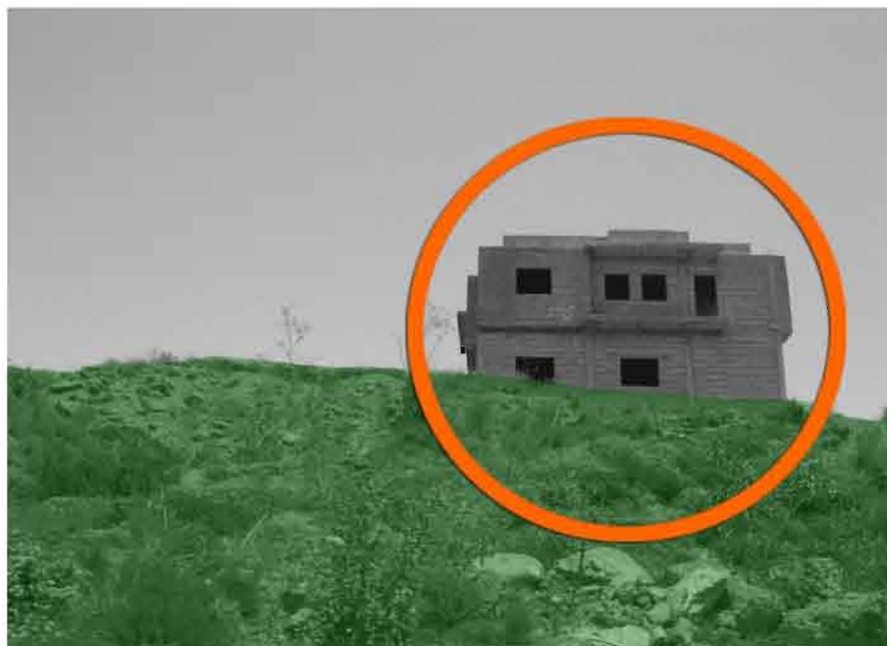
construcciones paralizadas en espacios naturales
