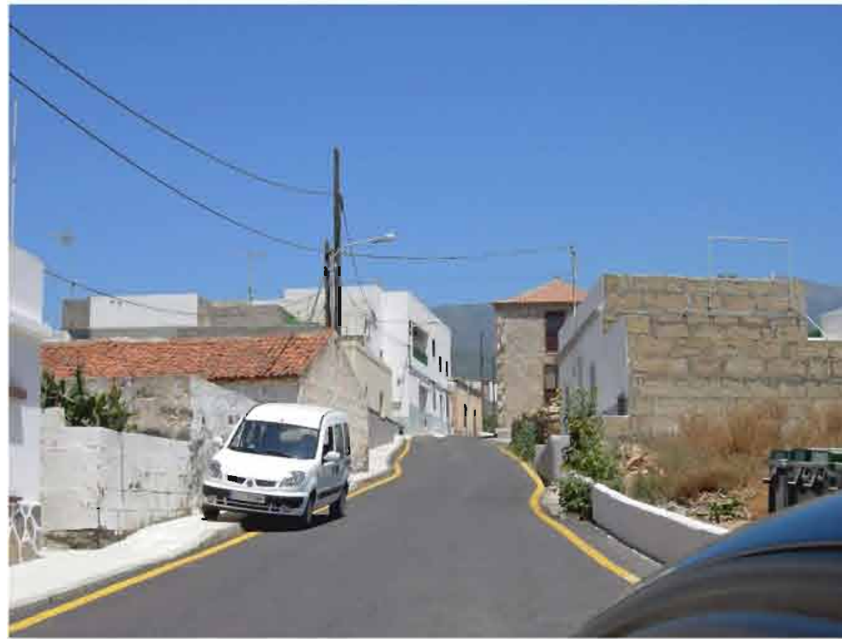
postes electricidad, telefono, luz...
