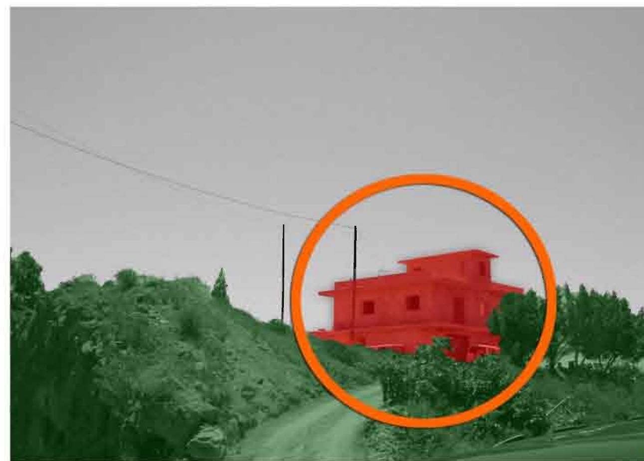
construcciones paralizadas en espacios naturales
