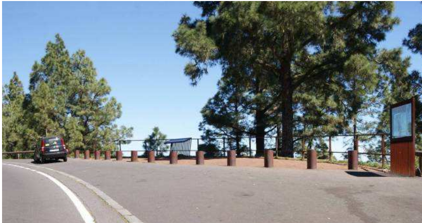
Mirador de Montaña Grande: área peatonal, al fondo, y área de estancia de vehículos en primer término. Un bordillo tumbado rebasable marca la separación del área de estacionamiento con la calzada. Además pivotes de acero corten separan el área de aparcamiento de los vehículos de la zona peatonal del mirador. Mobiliario diverso sirve a la contemplación e interpretación del paisaje.
