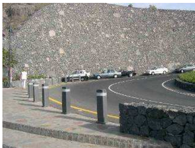
Encachado de piedra de muro de sujeción, barreras rígidas de muro y diseño específico. La elección de acabados y elementos singulares confiere personalidad y carácter a la carretera.
