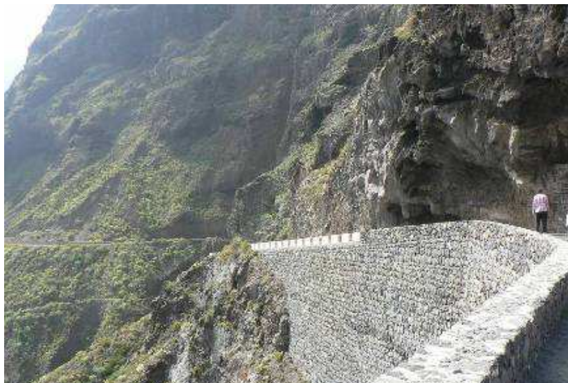
Encachado de piedra de un muro de sujeción y roca vista en talud de excavación. Las técnicas de aspecto tradicional (encachados de piedra) y el mantenimiento de la roca vista colaboran con la sensación de naturalidad.
