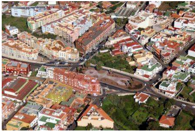
Ajardinamiento y contexto de la vía. Arriba: Glorieta de Tegueste. Ajardinamiento de signo urbano en la extensa glorieta lobular de Tegueste.
