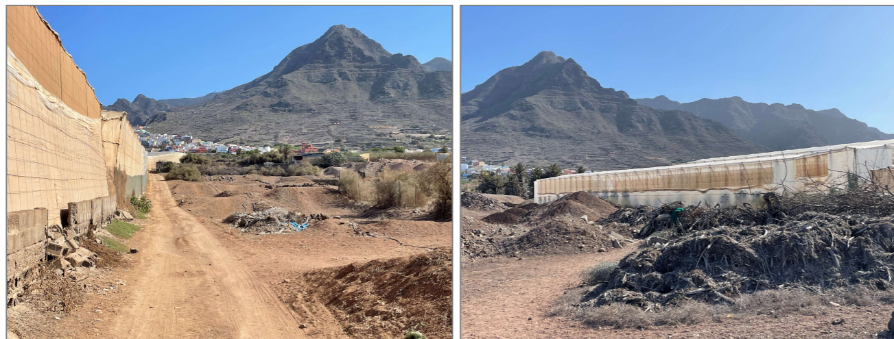
Figura 35 Plataformas conformadas por rellenos de origen antrópico
