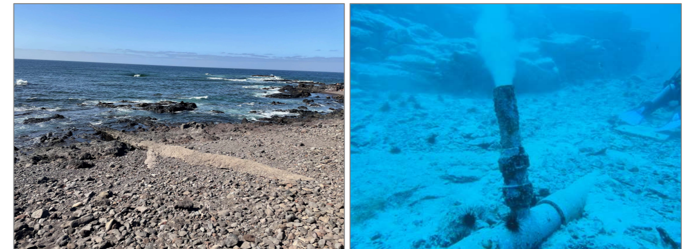
Figura 8 Entorno en el que se introduce el E.S. de Punta del Hidalgo en el mar (izqda.) y detalle de difusor (dcha).
