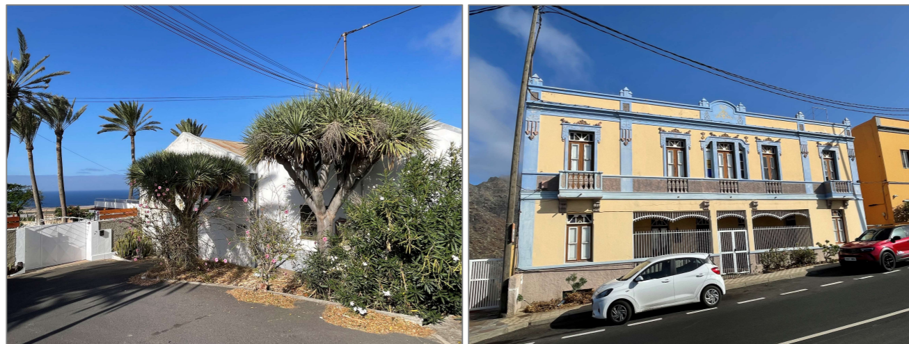
Figura 51 Detalle de la Finca El Millo (izqda.) y vivienda tradicional (dcha.)
