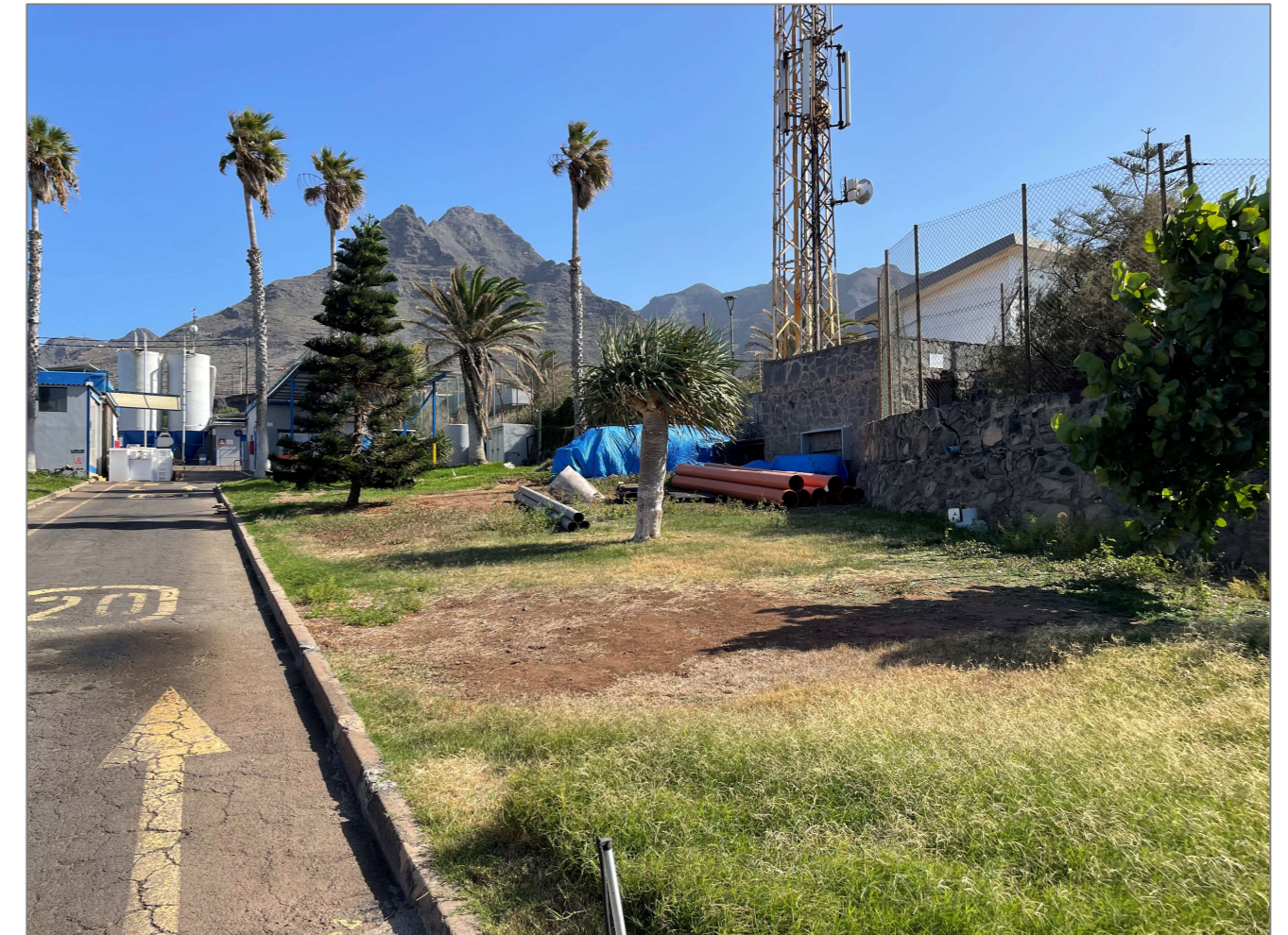
Figura 31 Vista del espacio interior de la EDAR de Punta del Hidalgo
