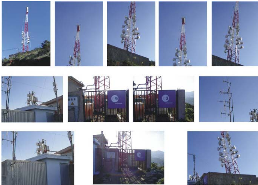
Instalación de radiodifusión situada en El Rosario
