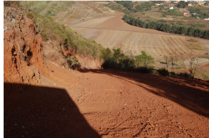
Foto N° 25: Pista de acceso a infraestructuras en Birmagen
