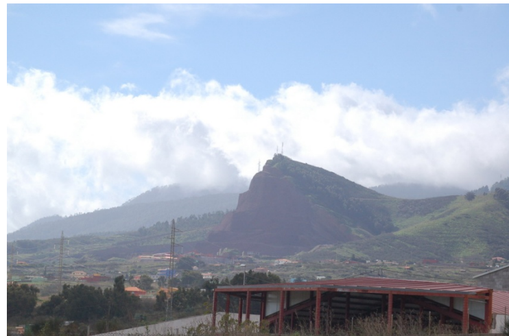
Foto N° 9: Vista de las infraestructuras de telecomunicación de Montaña Birmagen desde la TF-265 (Camino San Fco. de Paula)
