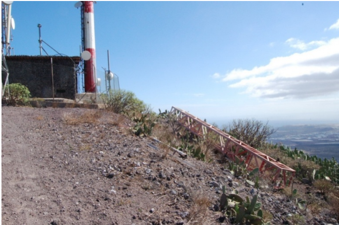
Foto N° 32: Restos de torre desmantelada en Montaña Gorda
