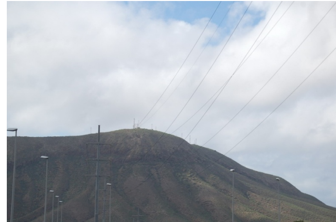
Foto Nº 7: Vista de las infraestructuras de telecomunicación de Montaña de Guaza desde la TF-1 (autopista del sur)
