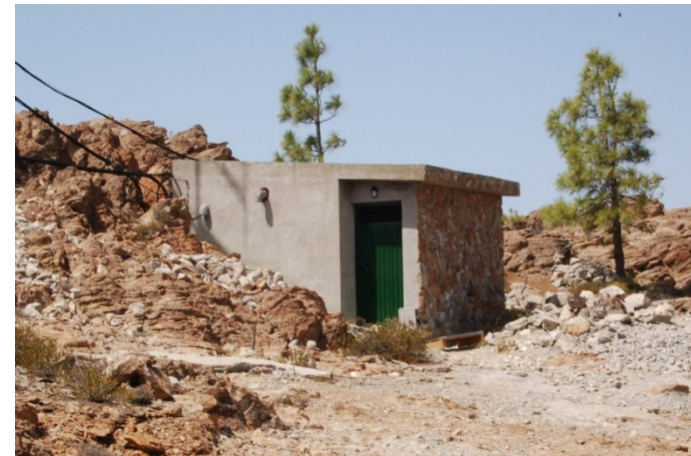
Foto Nº 13: Revestimiento parcial de caseta con piedra natural, inacabado aunque previsible correcta integración paisajística futura de caseta
