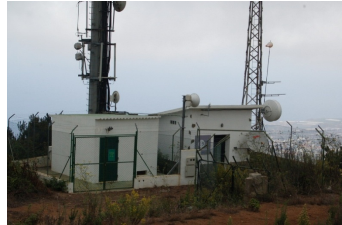
Foto N° 15: Escaso tratamiento de integración paisajística de casetas. La Vega (Icod)
