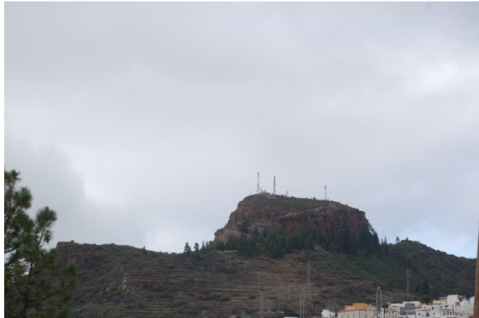
Foto Nº 6: Vista de las infraestructuras de telecomunicación de Arguayo desde la TF-375
