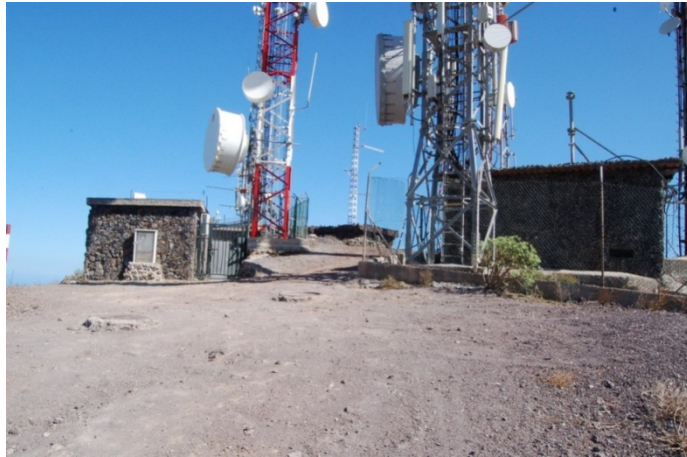
Foto N° 14: Revestimiento con piedra natural de casetas en Montaña Gorda. (Granadilla de Abona)
