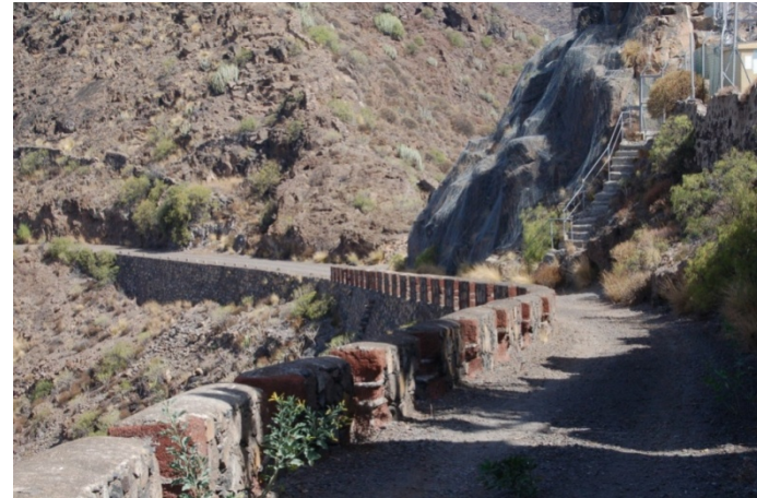
Foto N° 23: Pista de acceso a infraestructuras en Montaña la Alegría
