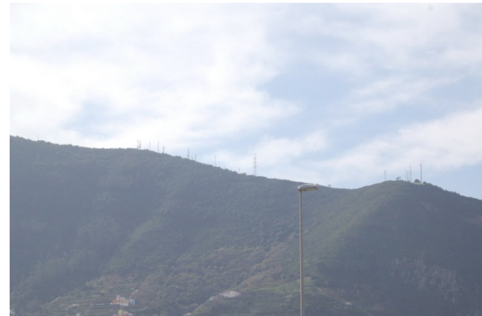
Foto Nº 5: Vista de las infraestructuras de telecomunicación de La Corona desde la TF-5 (Autopista del norte)
