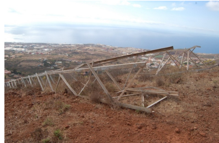
Foto N° 31: Restos de torres desmantelada en Montaña Talevera
