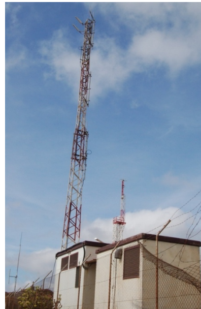
Foto N° 18: Torre con escaso número de antenas en Montaña Talavera
