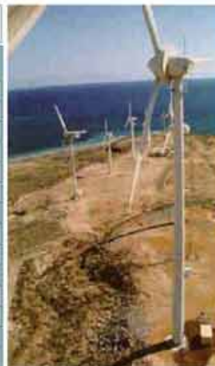
Imagen II.4.1.4.5.2. Aerogeneradores del I.T.E.R.
