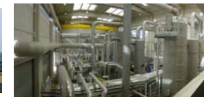
Edificio de secado térmico
