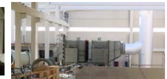
Edificio de cogeneración
