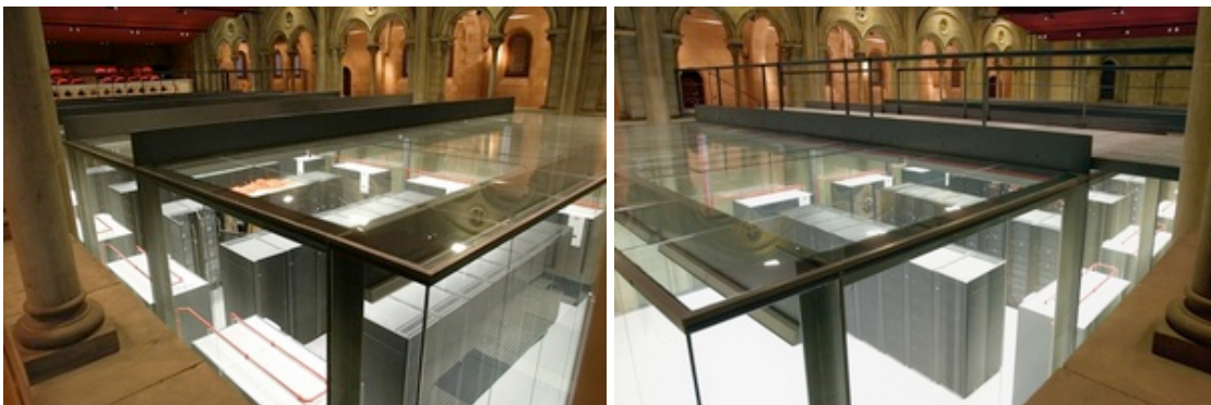
Figura 16.15. Supercomputador MareNostrum ubicado en el BSC-CNS
