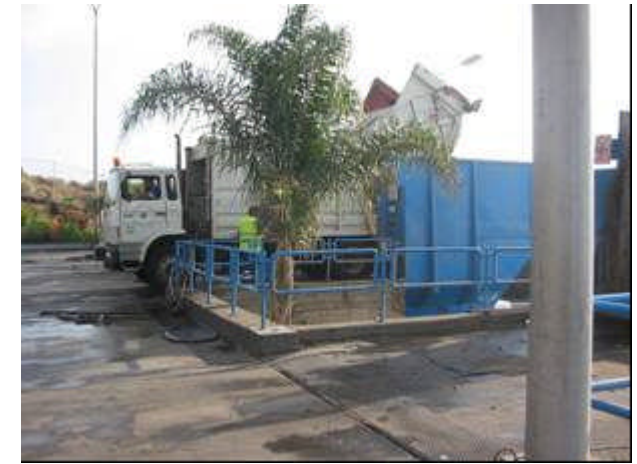
Foto 9. Zona de vertido y compactación de la ET "El Rosario".
