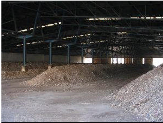
Foto 7. Vista de la nave de compostaje
