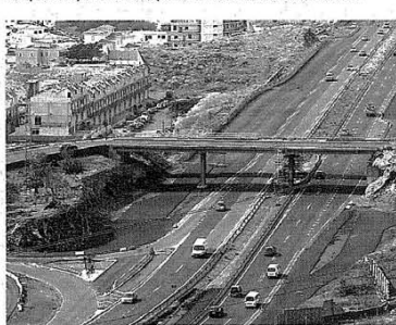
El director de las obras de la autopista, Adolfo Hoyos, reconoce que este proyecto es de 1998 y no se ha tenido en cuenta el paso del tren / S.B.
