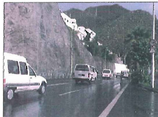
CARRETERA A SAN ANDRES TF-111
