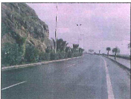
CARRETERA A SAN ANDRES TF-111
