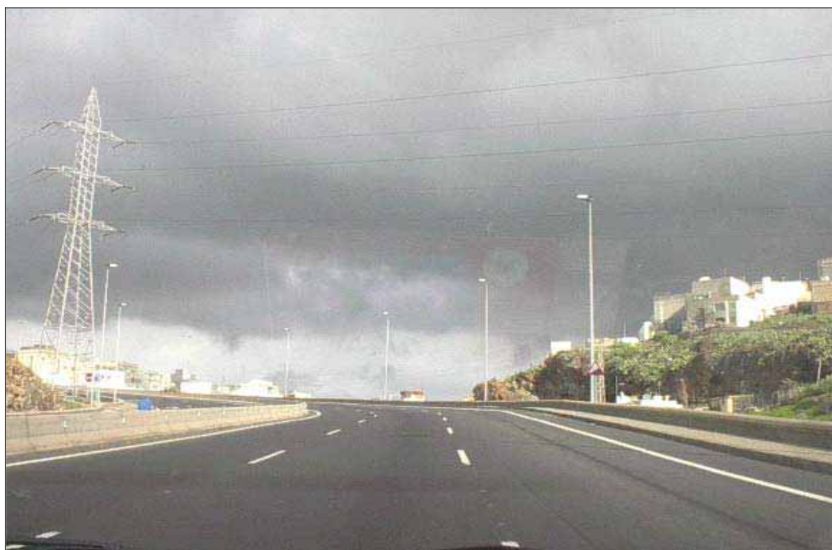
Autovía de conexión Santa María del Mar – Las Chumberas (TF-2).
