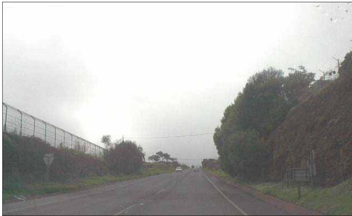
Carretera de La Esperanza (TF-24).
