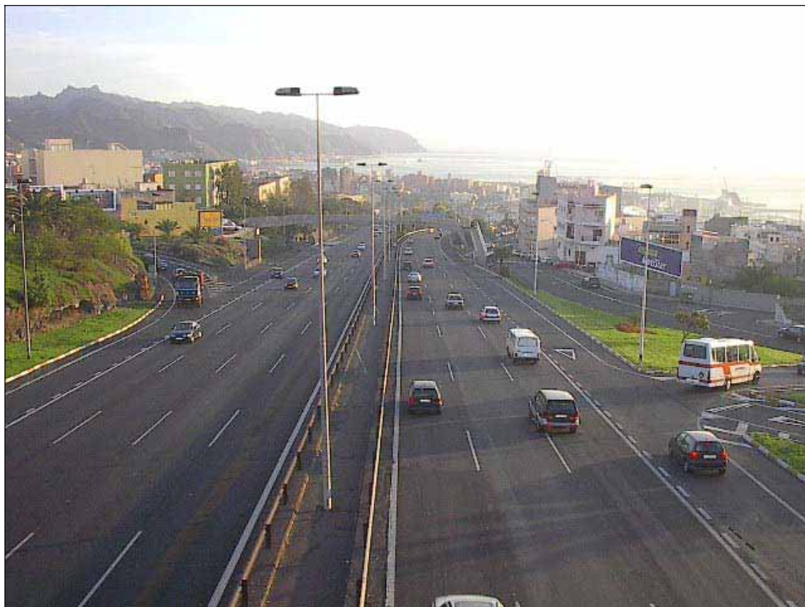
Conexión TF-5 con Carretera del Rosario.
