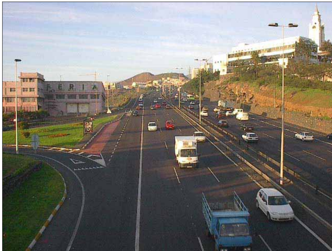
Ramales de entrada y salida de la Glorieta Vía de Enlace Norte – Sur.
