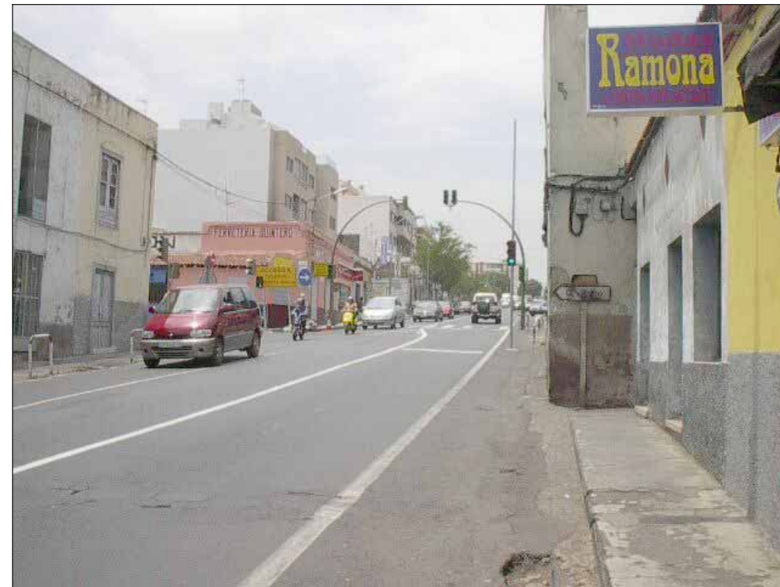
Carretera General Santa Cruz-La Laguna con la Carretera La Cuesta-Taco.
