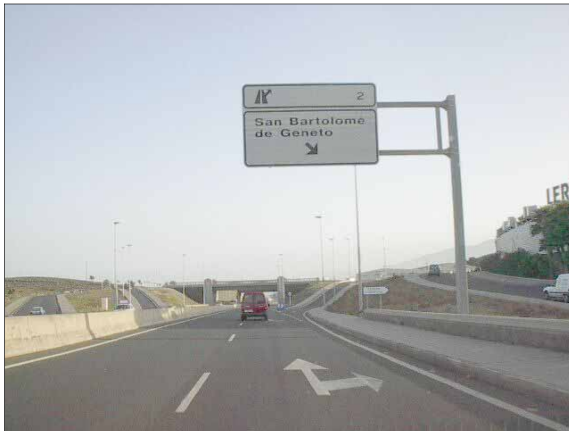
Enlace TF-2 con Carretera de San Bartolomé.
