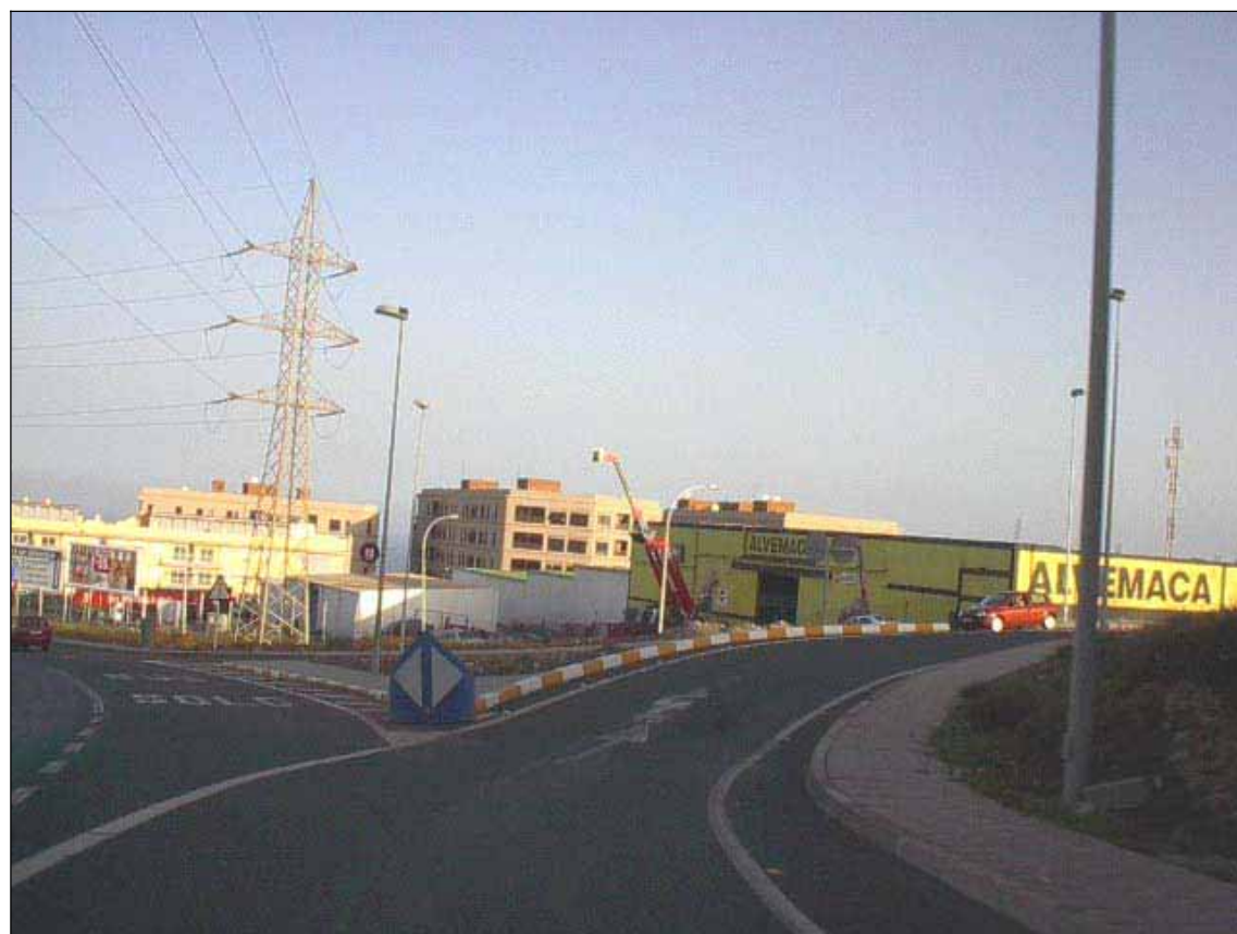
Enlace TF-2 con Carretera General del Sur.
