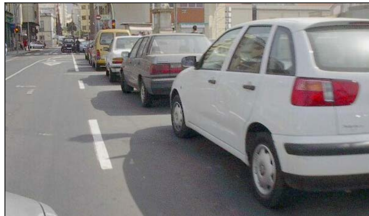
Vehículos estacionados en el Puente General Serrador, reduciendo en un carril la sección útil.
