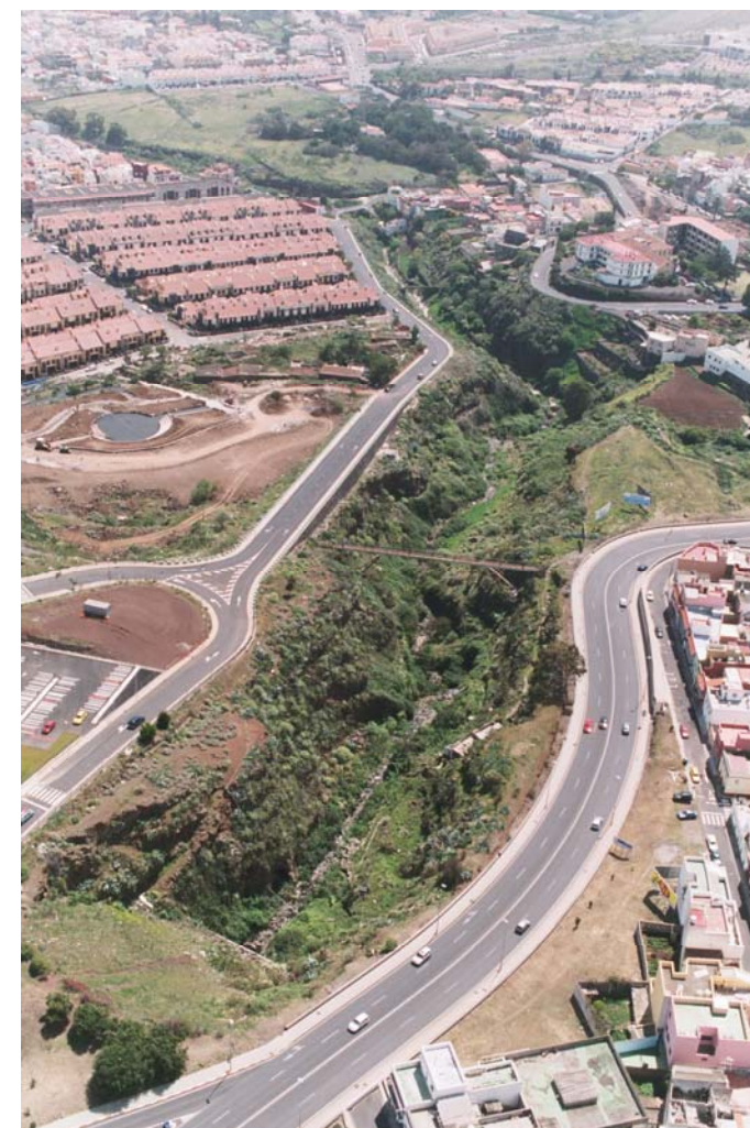
Barranco de Gonzalínez en el entorno urbano de La Laguna. El barranco se encuentra clasificado como suelo rústico de protección hidrológica.
