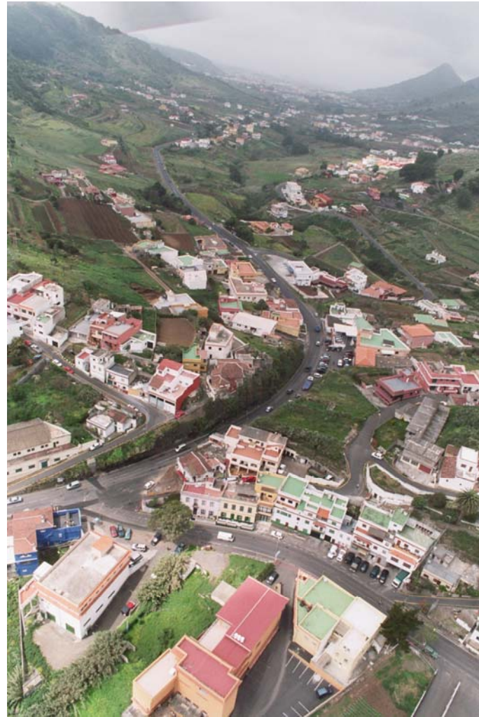
Suelos urbano de Las Canteras. En la actualidad, la conexión con la zona norte de El Rosario y Tegueste se efectúa por la TF-13.
