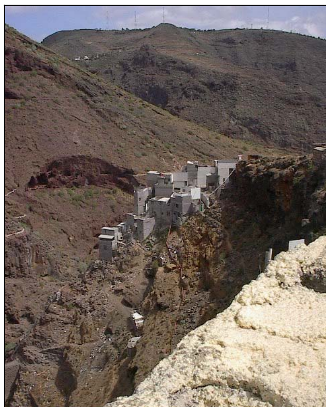
Autoconstrucción en el Barranco de Santos
