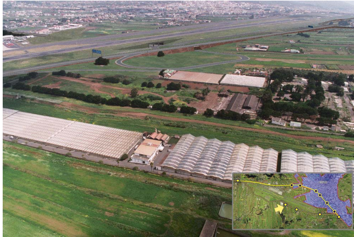
Enlace de conexión de la Circunvalación Oeste con el anillo de La Laguna
