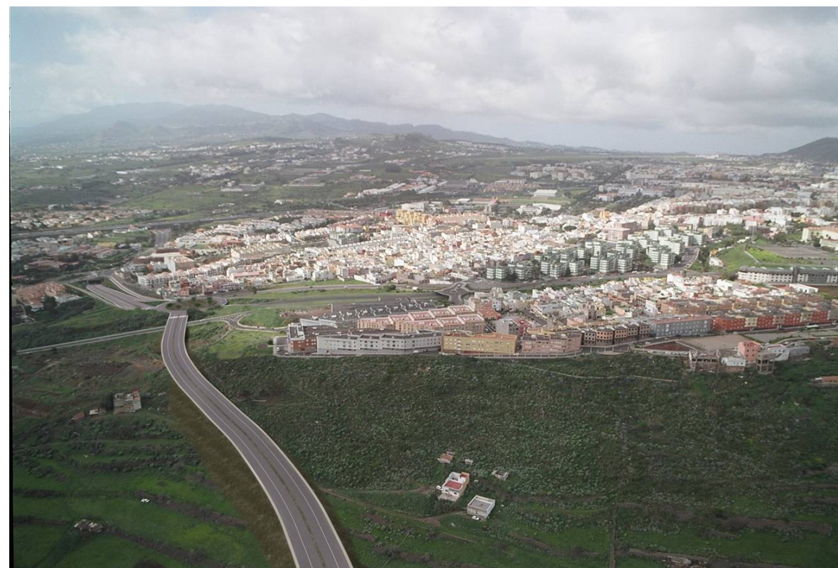
Tramo final de conexión de la Circunvalación Norte con la Vía de Ronda.
