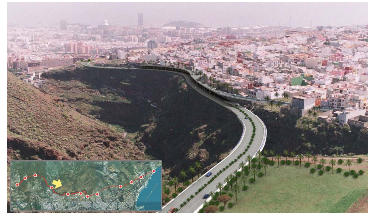
Paso de la Circunvalación Norte por el Barrio de Candelaria. Se puede observar el vial local que conecta con el Barrio y discurre elevado sobre la Circunvalación Norte.
