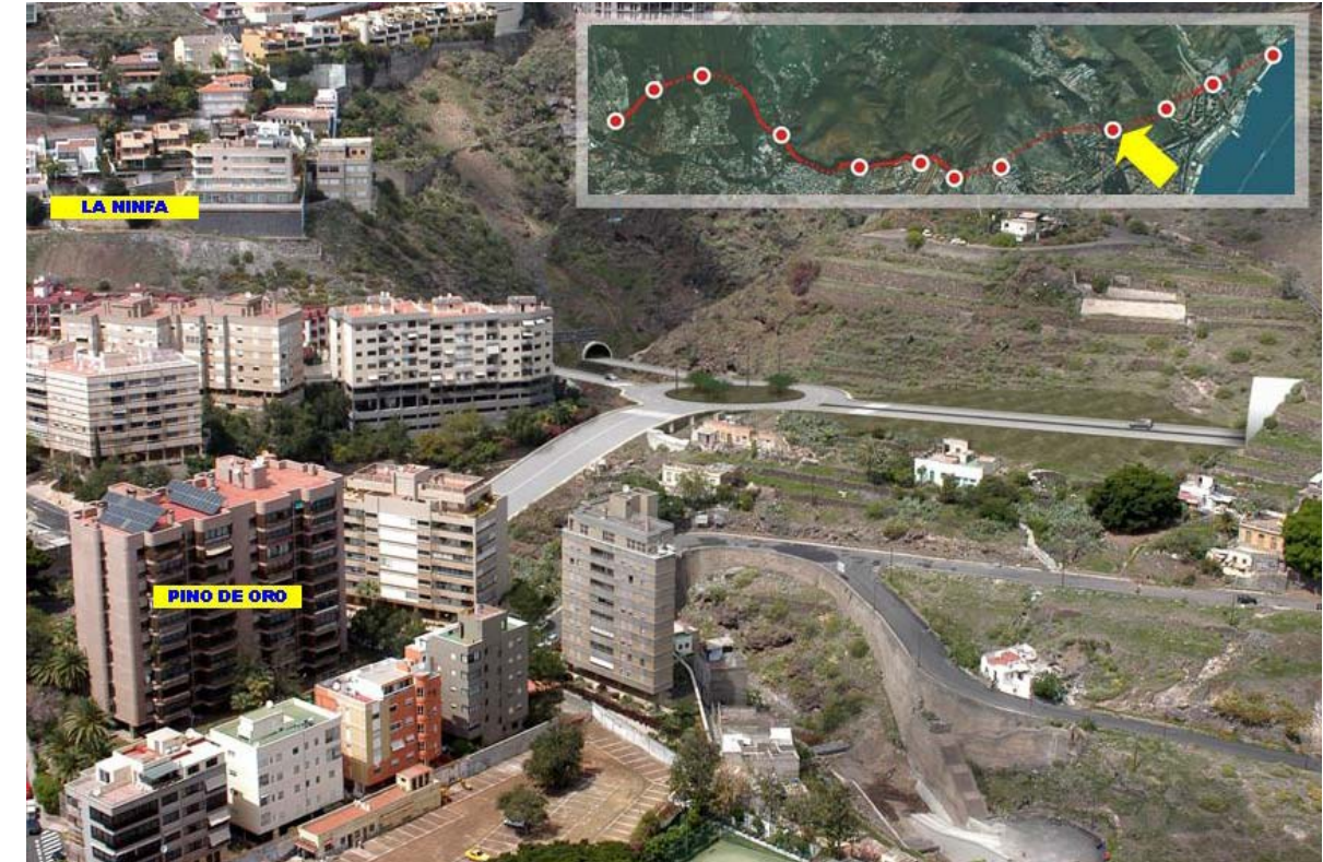
Vista de la Circunvalación Norte a su llegada a la Glorieta situada en el Barranco de Anchieta.
