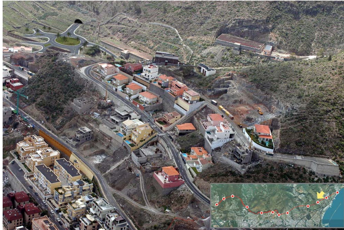
Vista de la Circunvalación Norte a su llegada a la Glorieta situada en el Barranco de la Leña, en las proximidades del Residencial Anaga.
