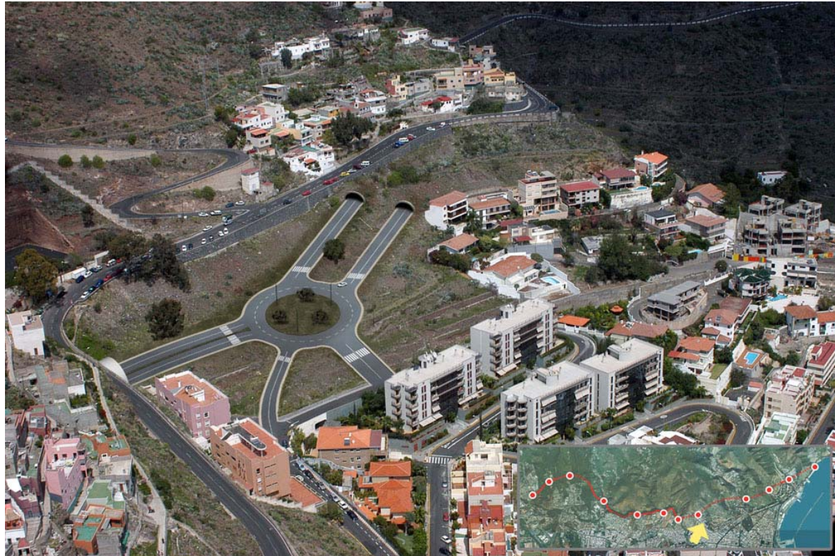
Salida de los túneles en el barrio de Las Acacias.
