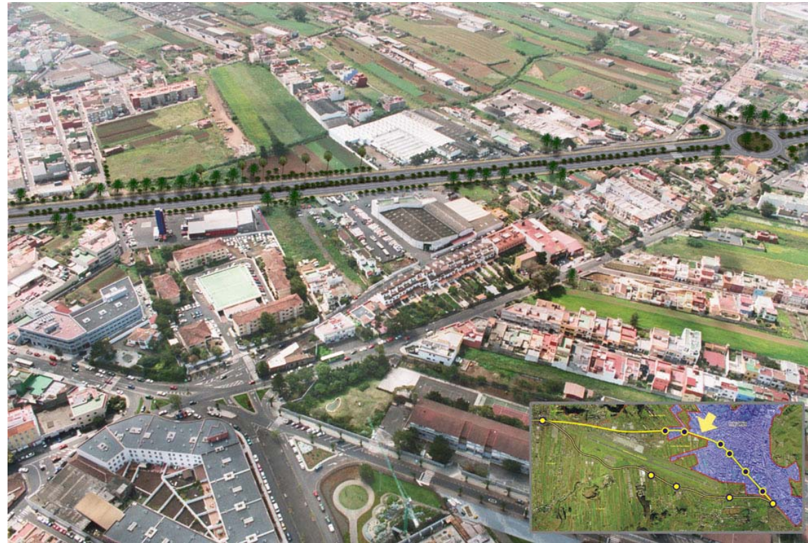
Vista de la Reconversión de la TF-5, en el tramo comprendido entre la glorieta situada en las proximidades de el Barrio de San Benito y la ubicada en San Lázaro.
