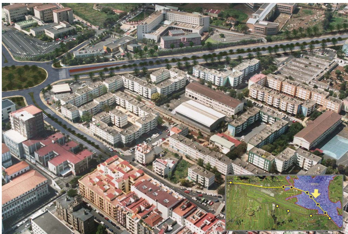
Tramo entre la Avenida Trinidad y la Calle República de Venezuela
