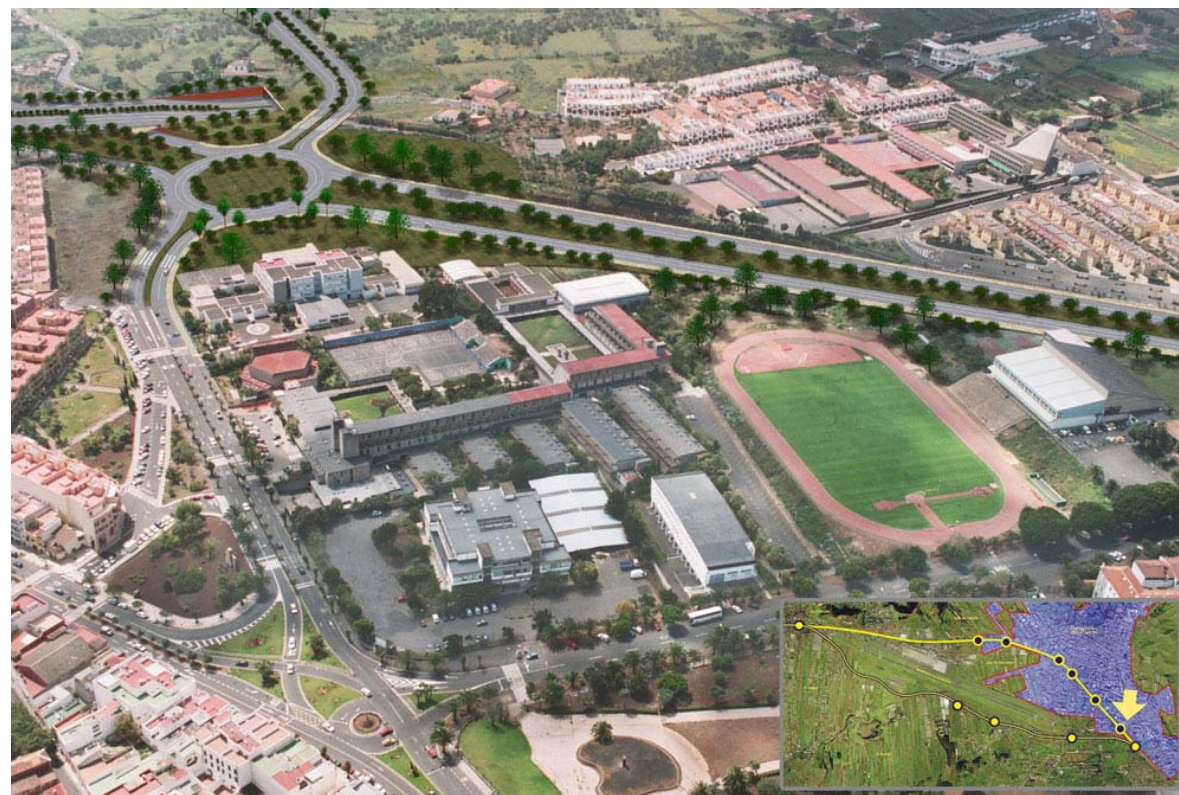
Vista de la Reconversión de la TF-5, en la glorieta que la conectará con la Avenida de Lora y Tamayo.
