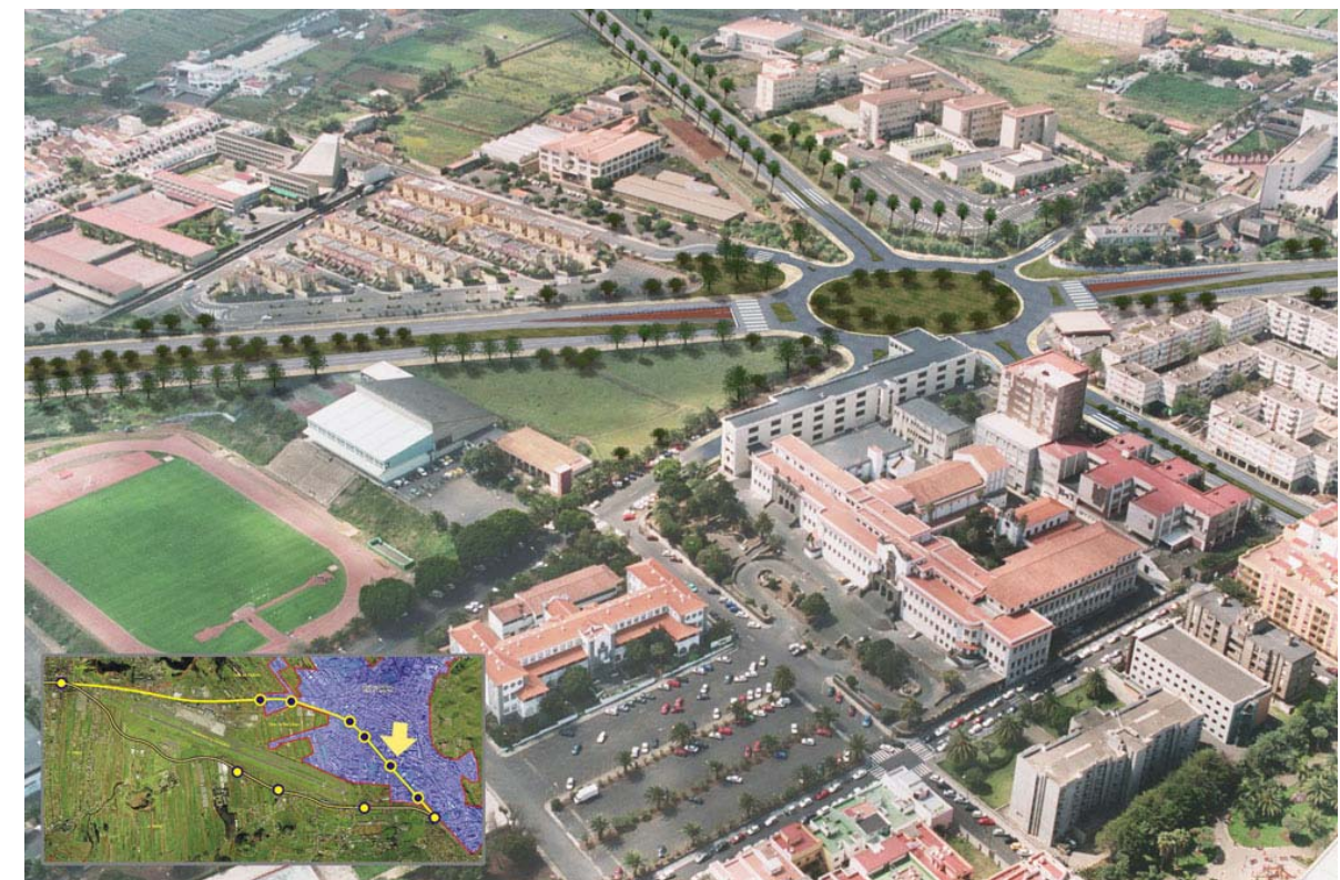
Vista de la Reconversión de la TF-5, en la glorieta que la conectará con la Avenida de La Trinidad.
