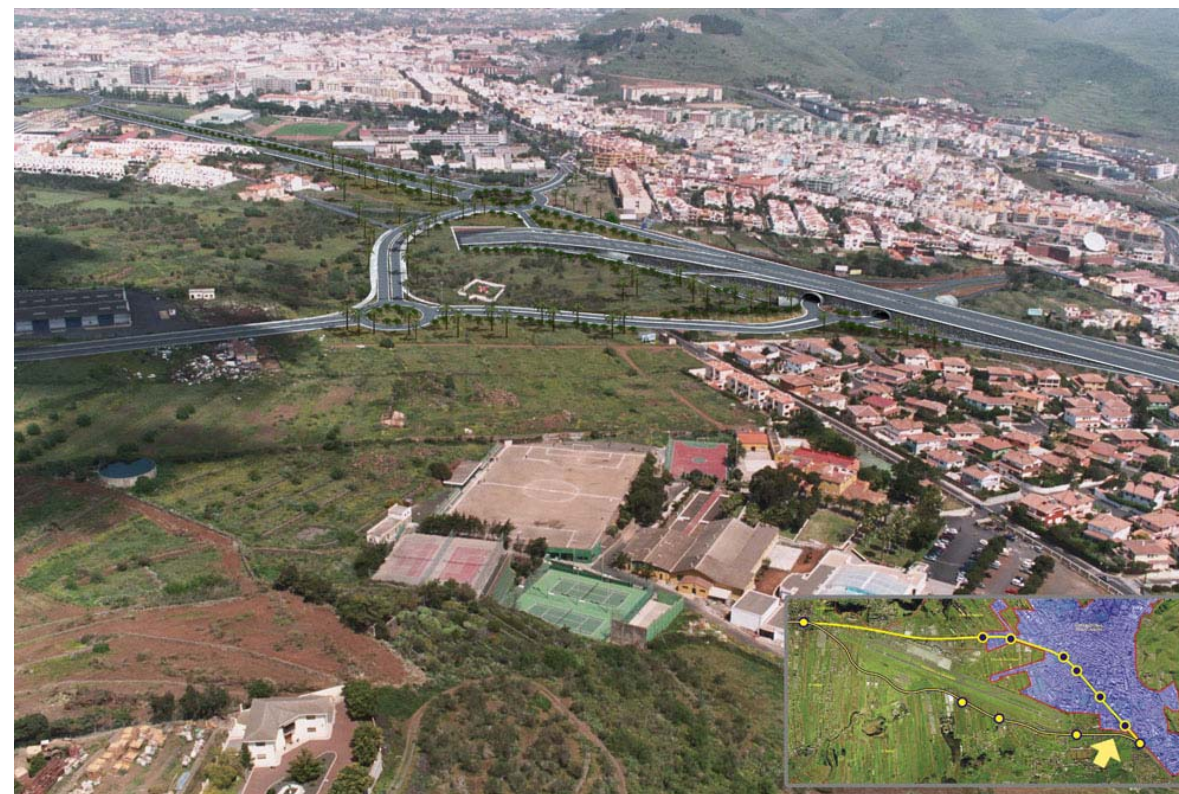
Vista de la conexión entre la Variante de la TF-5, la Vía de Ronda, la Ronda Sur y la Reconversión de la TF-5.
