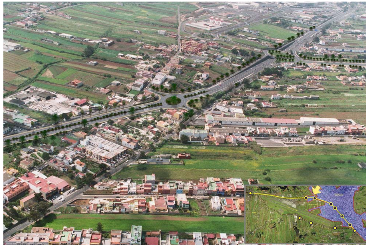
Vista de la Reconversión de la TF-5 hacia el Oeste, en su tramo final, ya en la conexión con la Ronda Oeste.
