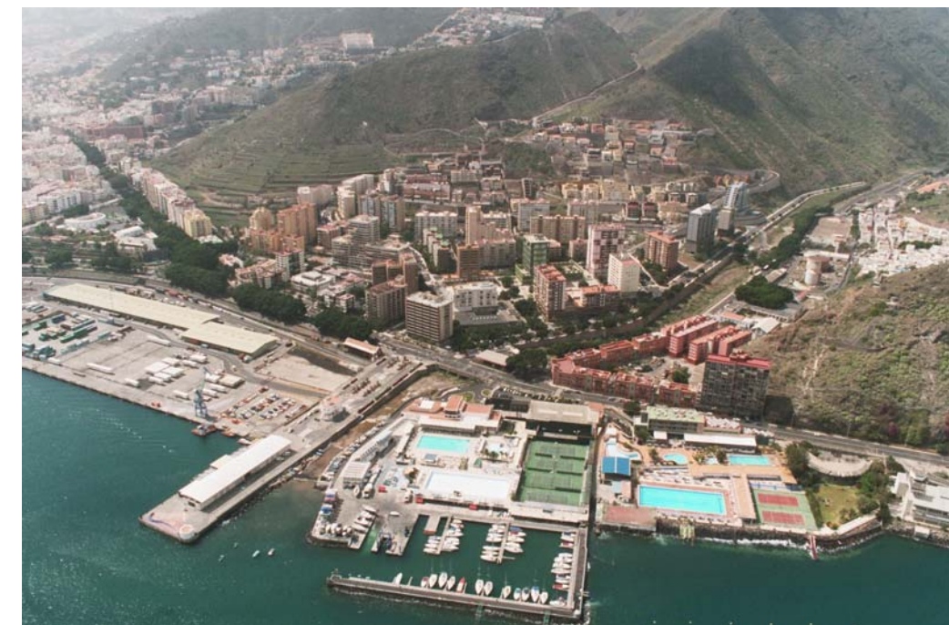
Actividades portuarias y diversas instalaciones relacionadas con el ocio se encuentran en el frente marítimo de Santa Cruz de Tenerife objeto de reordenación viaria.
