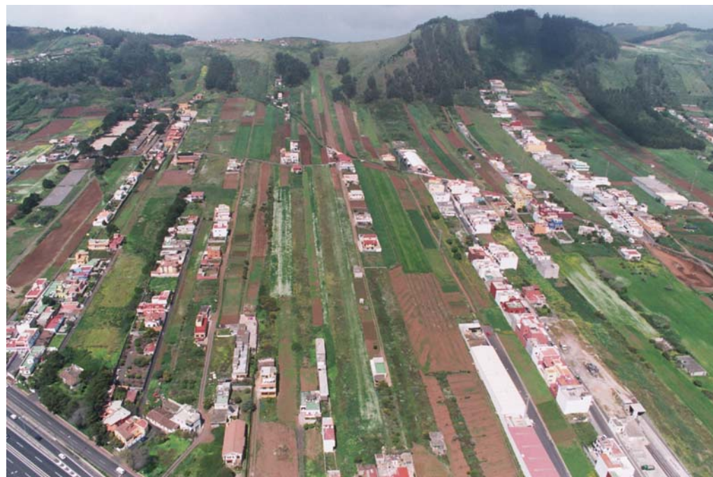
En el primer subtramo del Anillo de La Laguna, los usos agrarios y residenciales son los predominante en este sector de la Vega de La Laguna
