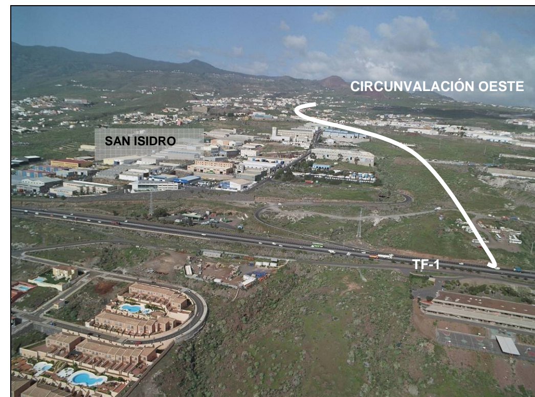
Circunvalación Oeste en su tramo final en la conexión con la TF-1.
